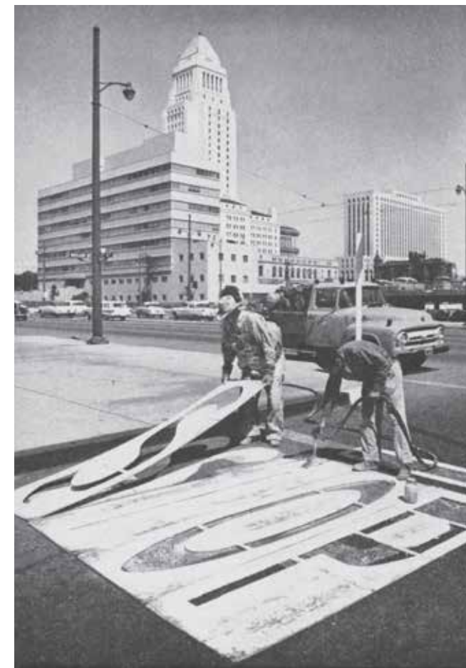
LINKS: Strassenmarkierung mit Sperrholzscha-blonen.
