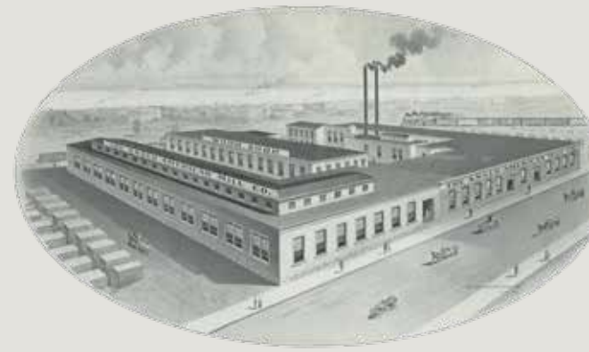
OBEN: Mayhew's Mühle in Owensboro, USA; Anglo-American Mill, Owensboro.
